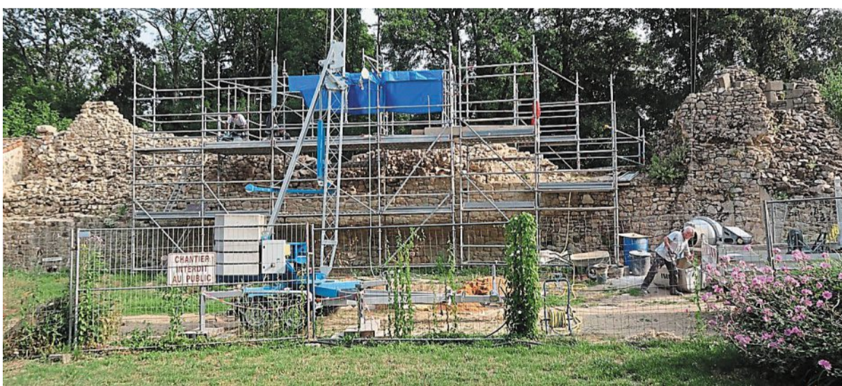
Après une pause en janvier-février, en raison du froid et de l'eau, les gros travaux ont repris en mars.
