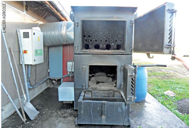
Le foyer en partie inférieure utilise l'air primaire pour la combustion. La partie supérieure en nid d'abeille se sert de l'air secondaire pour la circulation intérieure.
