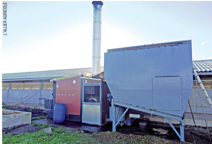
À l'arrière de la chaudière, la trémie d'une capacité de 15 m<sup>3</sup> alimente le foyer situé à l'avant, au fur et à mesure de ses besoins, par un système de vis.
